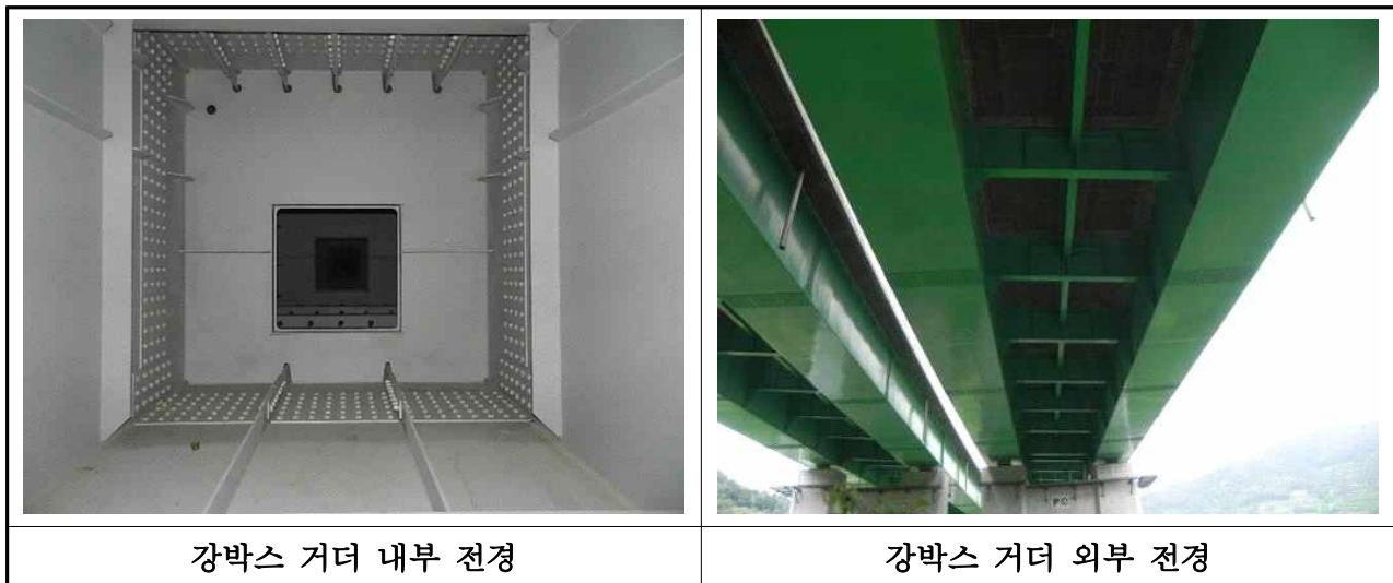
【사진 3.2.4】 강박스 거더 전경(대구)
