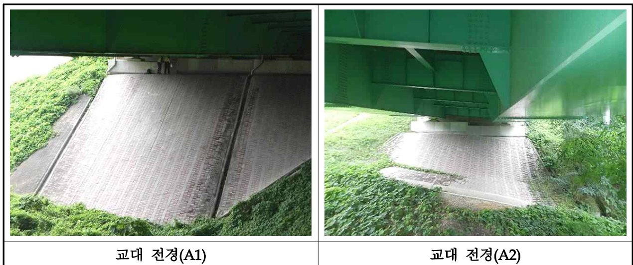
【사진 3.2.7】 교대 전경(대구)
