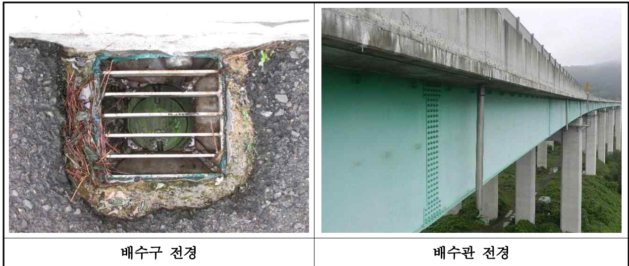
【사진 3.2.20】 배수구 및 배수관 전경(대구)
