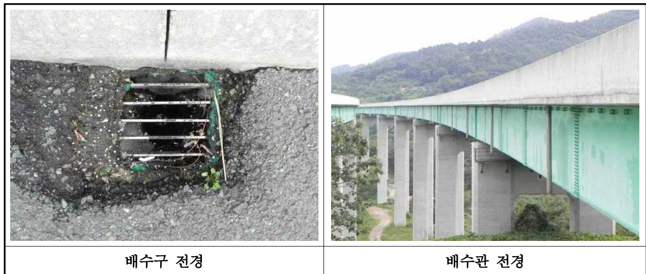
【사진 3.3.19】 배수구 및 배수관 전경(부산)
