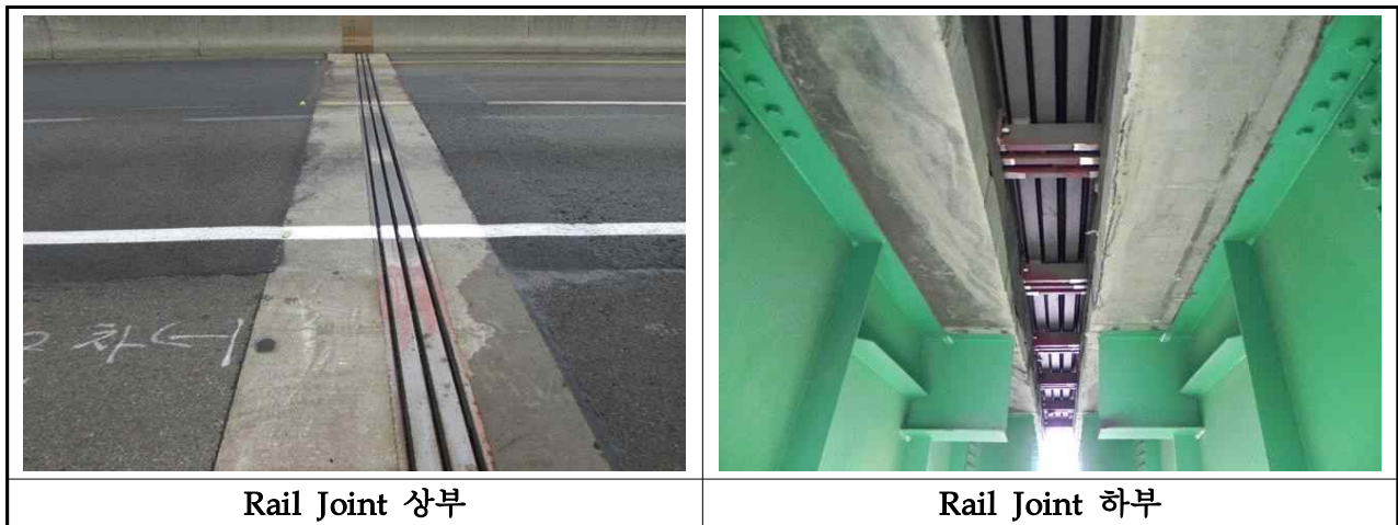
【사진 3.2.15】 신축이음장치 전경(대구)
