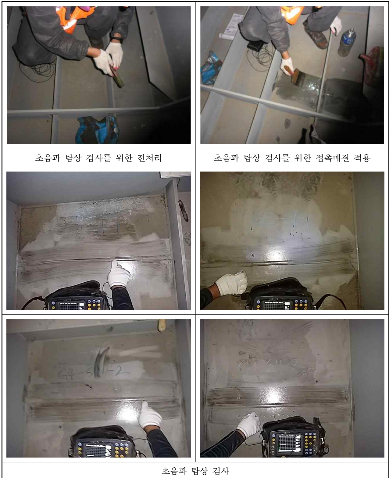
【사진 3.5.1】 강재 내구성조사 전경
