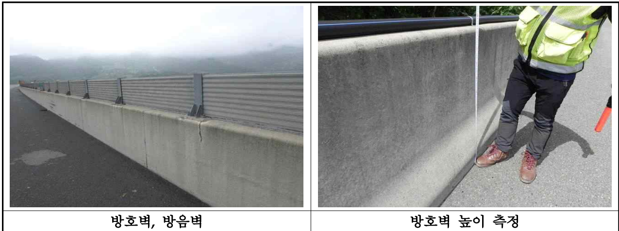
【사진 3.2.21】 난간 및 연석 전경(대구)
