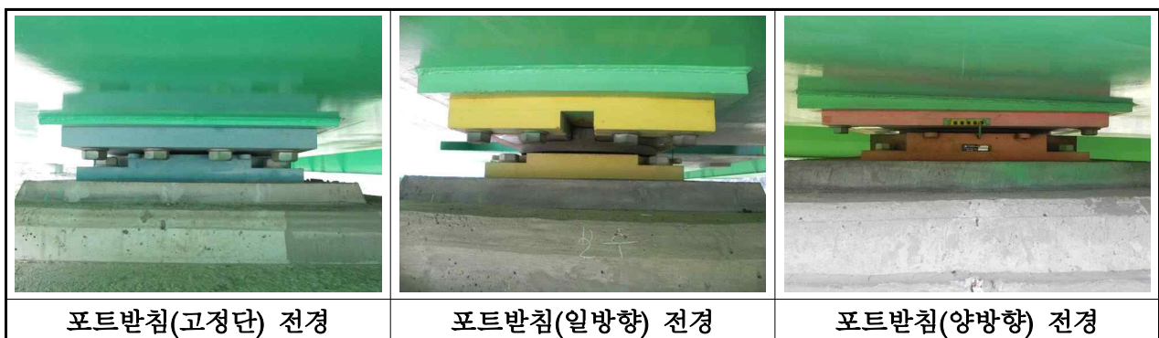
【사진 3.3.11】 교량받침 전경(부산)
