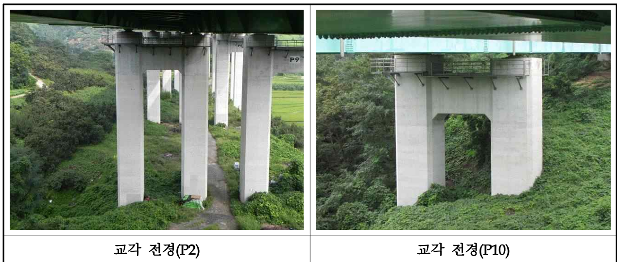
【사진 3.3.8】 교각 전경(부산)
