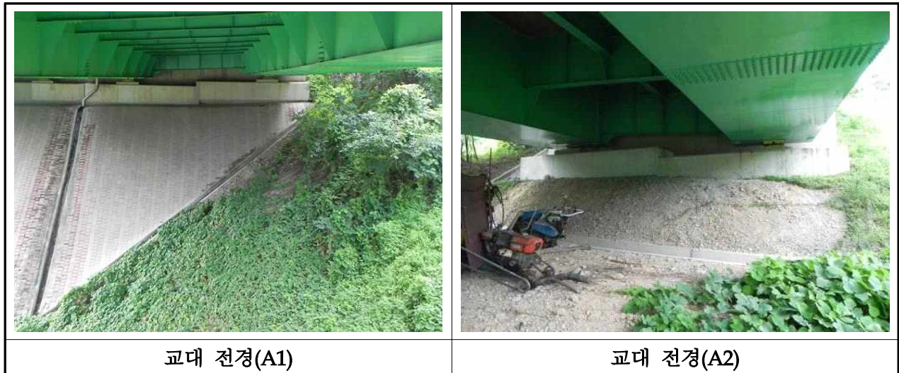
【사진 3.3.6】 교대 전경(부산)
