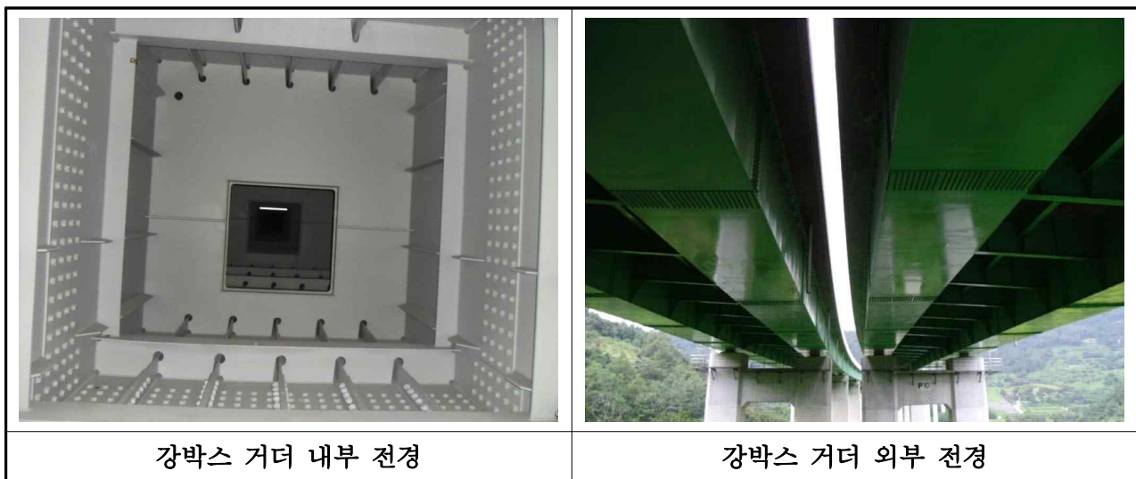
【사진 3.5.3】 강박스 거더 전경(부산)
