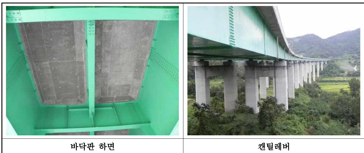
【사진 3.2.1】 바닥판 전경(대구)
