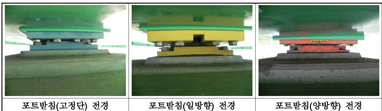
【사진 3.2.12】 교량받침 전경(대구)
