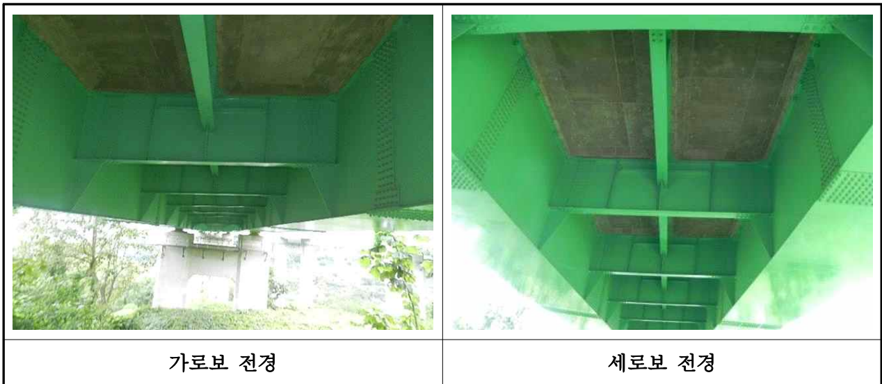
【사진 3.2.6】 가로보 및 세로보 전경(대구)
